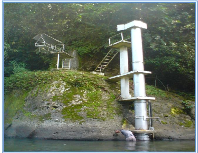
Fig. 9 Pozo amortiguador y carro de aforo de la estación Puerto Palenque, río Teribe.
