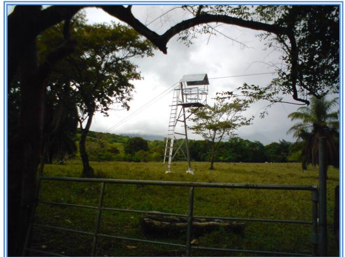
Fig. 53 Torre y carro de aforo en el río Santa María en Santa Fe.
