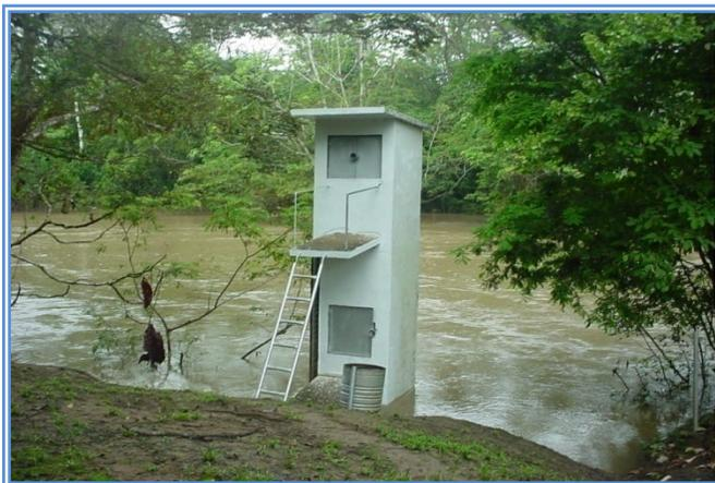
Fig. 64 Pozo amortiguador, estación hidrológica Laja Blanca.
