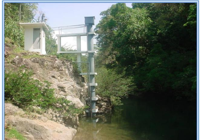
Fig. 61 Estación hidrológicas satelital y limnográfica, Aguas Claras.
