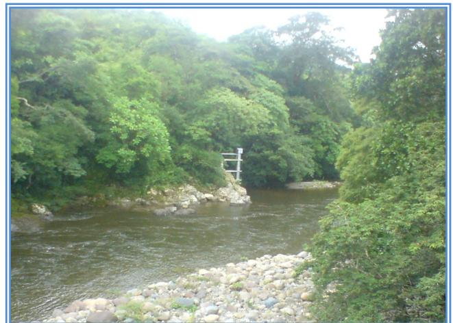
Fig. 42 Limnógrafo construido sobre la roca que sirve de protección contra crecidas del río.
