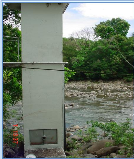
Fig. 25 Pozo amortiguador, río La Esperanza.
